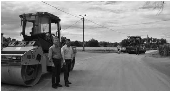
Asfaltowanie ul. Czechowickiej w Kaniowie
