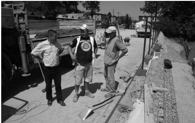
Wójt Artur Beniowski na budowanym parkingu
