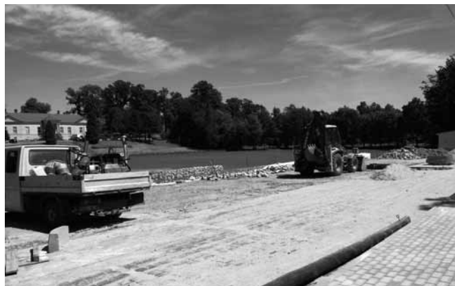
Budowa parkingu przy ul. Podzamcze
