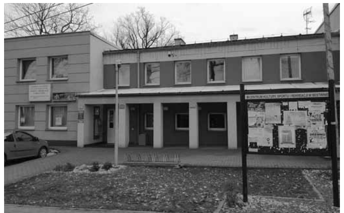
Budynek Centrum Kultury w Bestwinie
