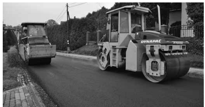
Asfaltowanie ul. Kościelnej
