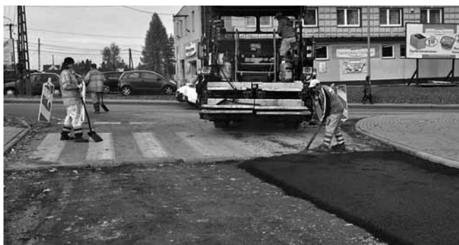
Roboty drogowe na ul. Podzamcze
