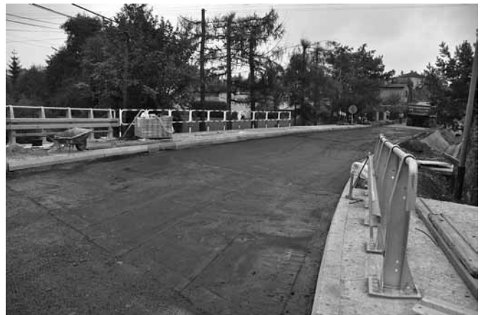
Asfaltowanie mostka na ul. Kościelnej
