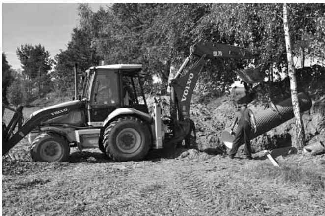
Wykonywanie przepustu pod ul. Kóska
