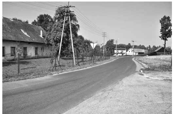
Wyremontowany ciąg komunikacyjny w Bestwinie
