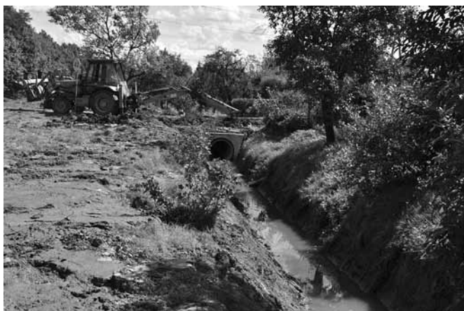
Wykonywanie przepustu - ul. Pastwiskowa i Braci Dudów
