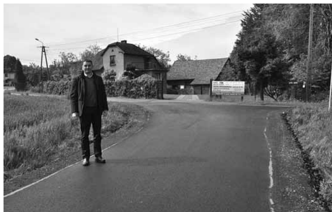
Zastępca wójta Marcin Kanik na wyremontowanej ul. Łanowej
