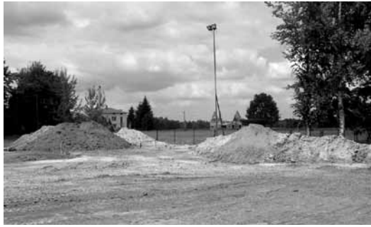
Plac budowy boiska
