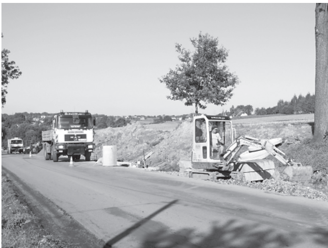
Budowa chodnika na Magówkę.
