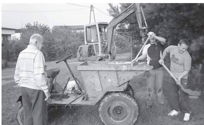
Prace przy wykonywaniu ogrodzenia.
