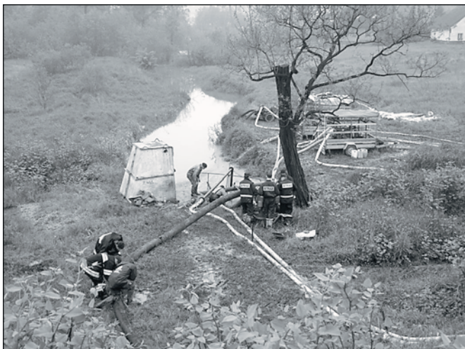
Pompy pracują (fot. J. Zużalek).
