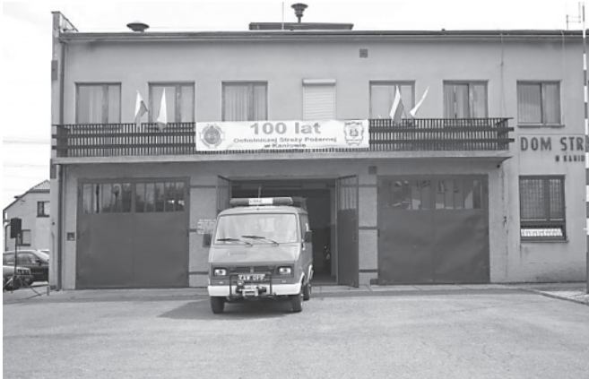
Dom Strażaka w Kaniowie - stan przed modernizacją (fot. OSP Kaniów)
